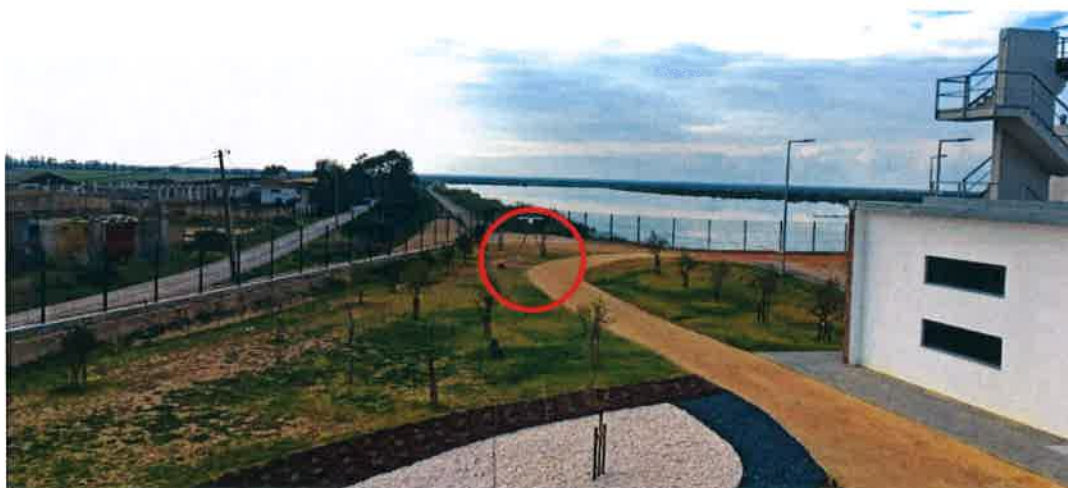
Figura 5 – Segunda localização do radar na ETAR de Faro-Olhão. É notório que o edifício da ETAR (à direita na imagem), pela sua altura e localização, corta o feixe do radar, gerando uma zona de sombra para as aves a voar a baixa altitude.
