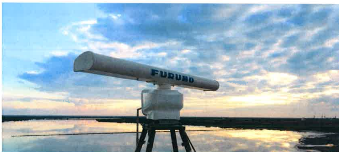
Figura 4 – Radar em disposição horizontal na ETAR de Faro-Olhão.
