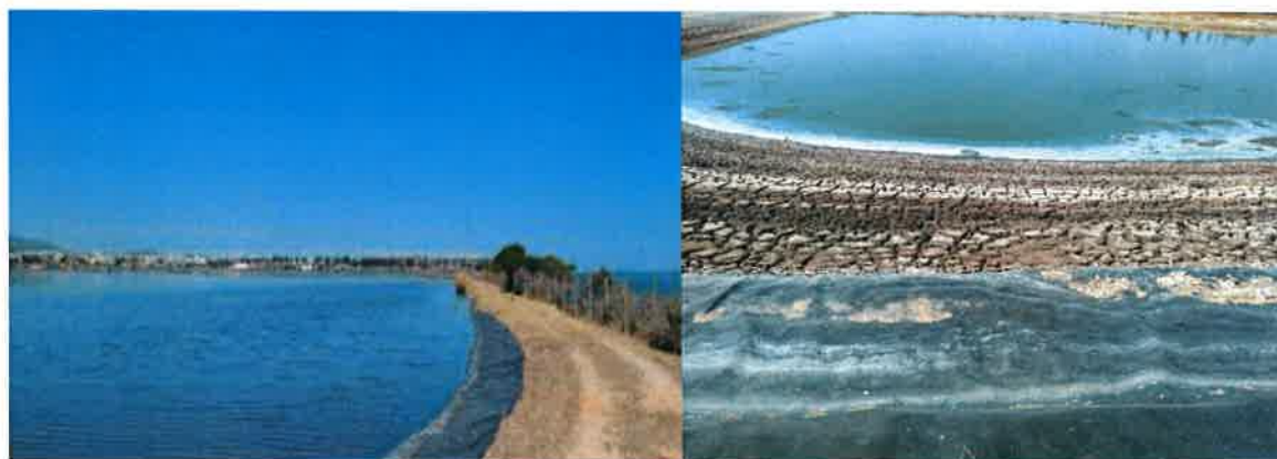
Figura 10 – Lagoa A2 da ETAR de Olhão-Poente: à esquerda – lagoa antes da desativação da ETAR; à direita – após a desativação da ETAR (31-07-2019).
