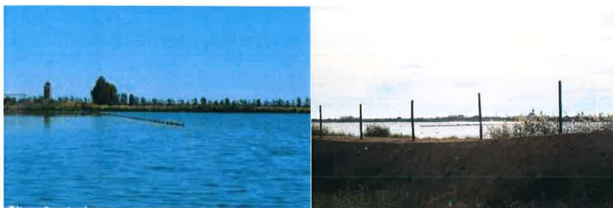
Figura 12 – Lagoa intermédia ou facultativa da ETAR de Faro-Olhão: à esquerda – lagoa antes das obras da ETAR; à direita – após as obras da ETAR (10-12-2019).
