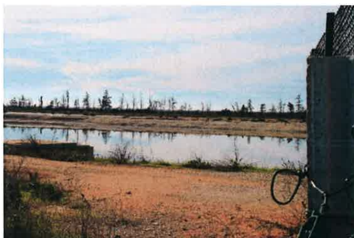
Figura 9 – Aspeto atual da lagoa anaeróbia da EEAR de Olhão (10-12-2019).
