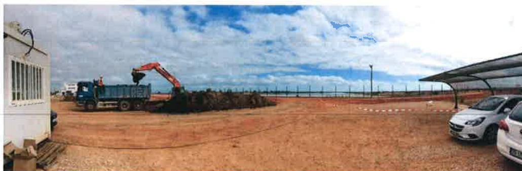
Figura 6 – Movimentação de terras na proximidade do radar durante a campanha de outubro de 2018.
